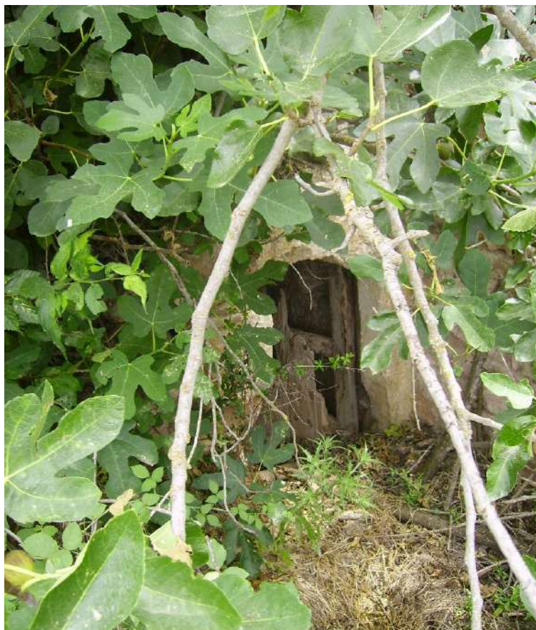
La vegetación oculta los restos constructivos y un portalón que daría acceso a los aljibes.
