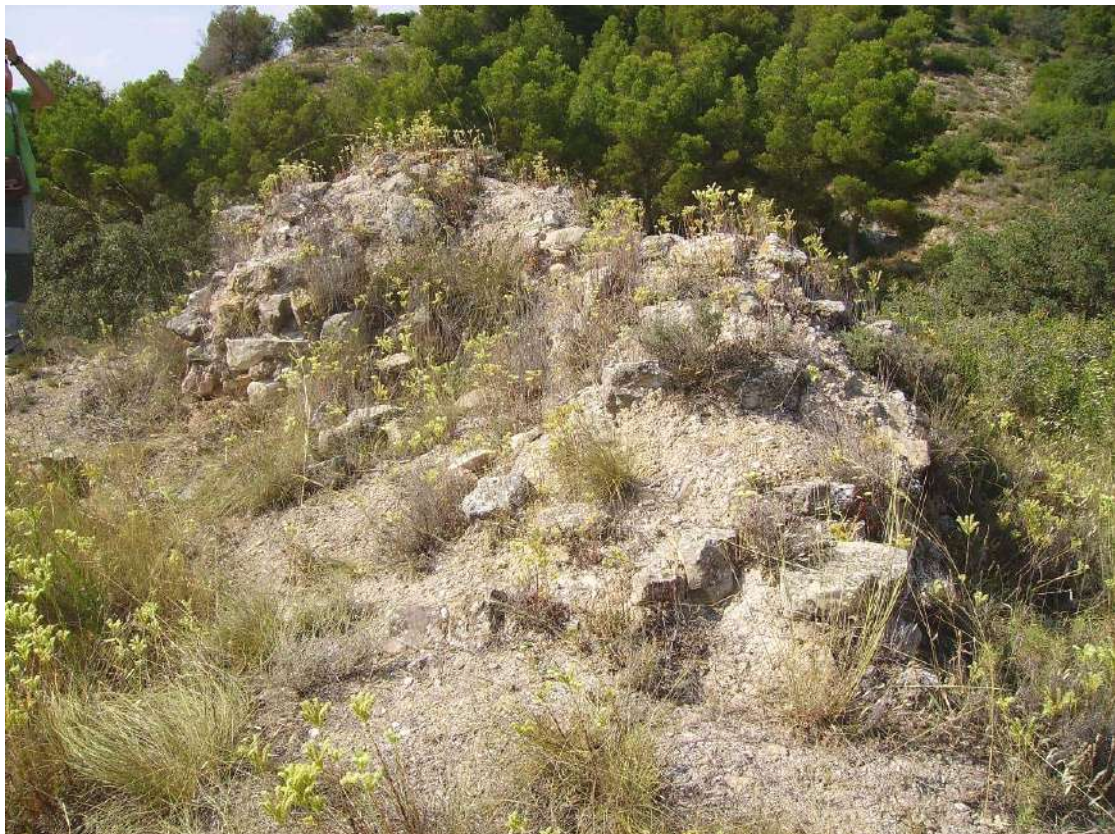
Detalle de los restos constructivos que aún se mantienen en pie.
