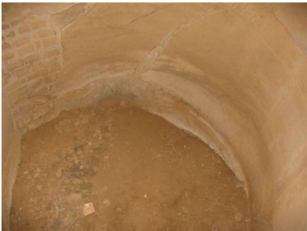
Cúpula semicircular del pozo, y base del mismo, en el que se almacenaba el hielo y la nieve.
